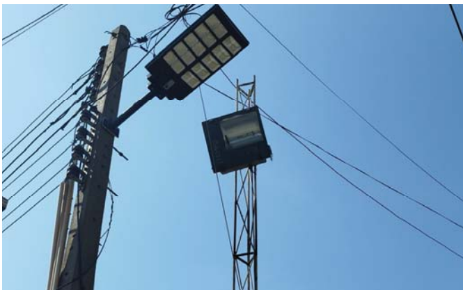
ไฟสปอร์ตไลท์ที่ติดตั้งบนเสาเหล็กสูงประมาณ 6 เมตร และโคมไฟ LED แบบกึ่งเคียวส่งไปยังประตูทางเข้า-ออกโครงการ
