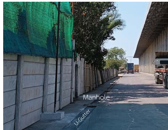
แนวร่องระบายน้ำ (U-Gutter) และบ่อพักน้ำ พร้อมฝาตะแกรงเหล็กดัดฝั่งริมรั้วทิศใต้
