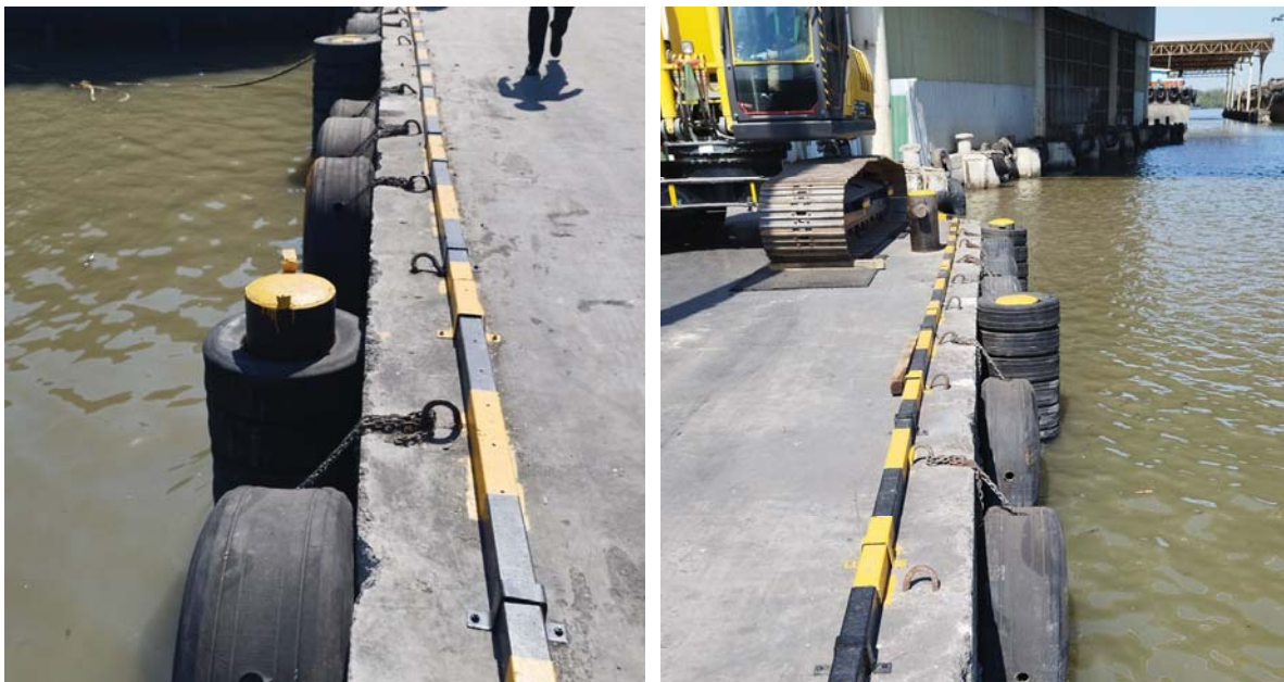
รูปที่ 2.3.4-9 สภาพปัจจุบันของหลักกันกระแทก ยางกันกระแทกและคั่นขอบปูนเดิม
