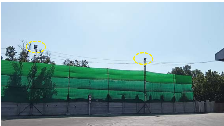
ไฟสปอร์ตไลท์ที่ติดตั้งบนเสาเหล็กสูงประมาณ 12 เมตร ริมรั้วด้านทิศใต้ ส่งไปยังลานจอดรถบรรทุกต่อเนื่องหน้าท่า
