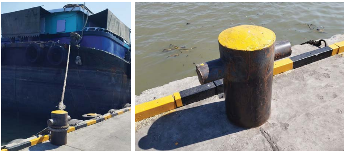
รูปที่ 2.3.4-7 สภาพปัจจุบันของหลักผูกเรือ
