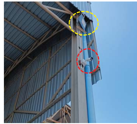
ไฟสปอร์ตไลท์ที่ติดตั้งบนเสาเหล็กด้านทิศเหนือ ส่งไปยังหน้าท่า
