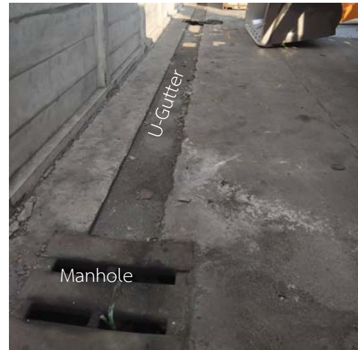
ระบายน้ำขนาดเล็ก (U-Gutter) และบ่อพักน้ำ พร้อมฝาตะแกรงเหล็กดัดฝั่งริมรั้วทิศเหนือ
