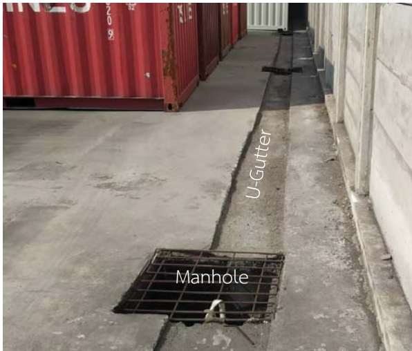
ระบายน้ำขนาดเล็ก (U-Gutter) และบ่อพักน้ำ พร้อมฝาตะแกรงเหล็กดัดฝั่งริมรั้วทิศเหนือ
